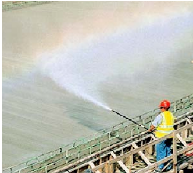
Resim – 2 : Betonun nemlendirilmesi
